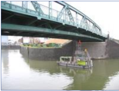
Bauwerksprüfung mit Arbeitsboot und Gerüst
